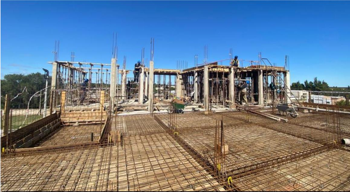
Vista – Armado de Columnas y Vigas. SECTOR C – 4to piso.
