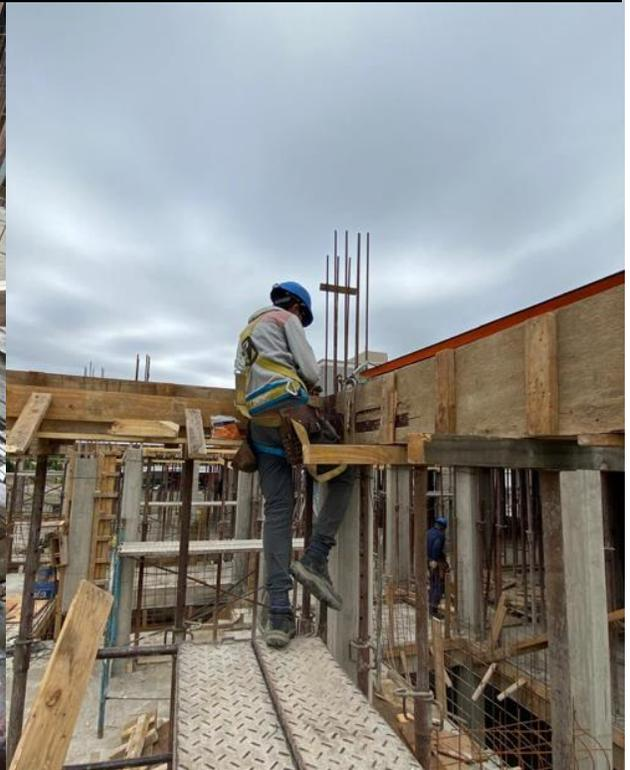
Tareas de armado de Viga con puntos de anclajes
